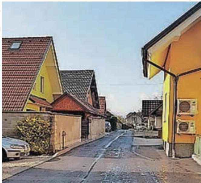
Občina je zaključila dela na dveh odsekih v KS Sebenje.
