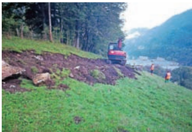
Občina bo sanacijo vodohrana zaključila v prihodnjem letu.
