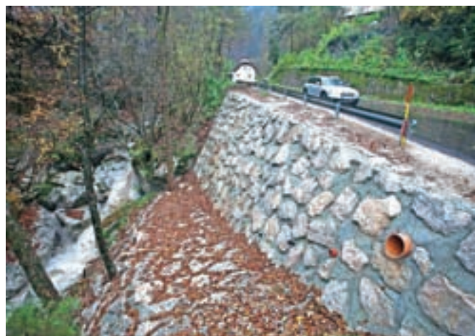
Saniralo se je tudi v Lomu, nov oporni zid nad Lomščico.
